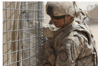
SSG Fontejon lines up Hesco wall.
